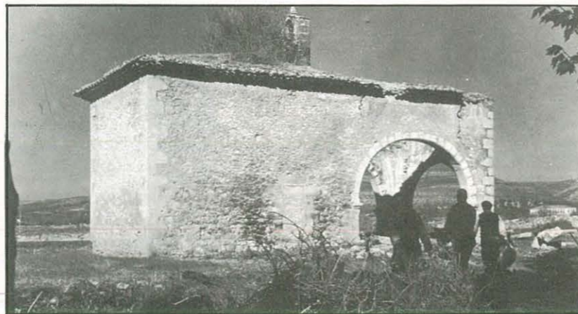
Tal y como estaba el humilladero de Loreto antes de su restauración, cuya obra fue subvencionada a fondo perdido. Año 1963
